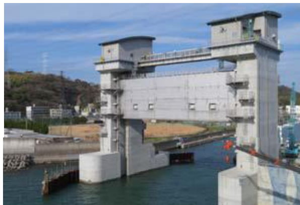
和歌山下津港（海南地区）海岸保全施設
