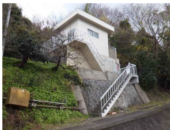
【青枝ポンプ室】（下津水道事業）
