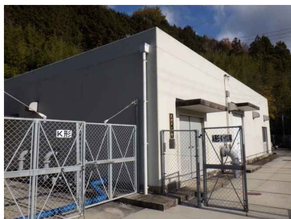
【大池ポンプ所】（海南水道事業）
