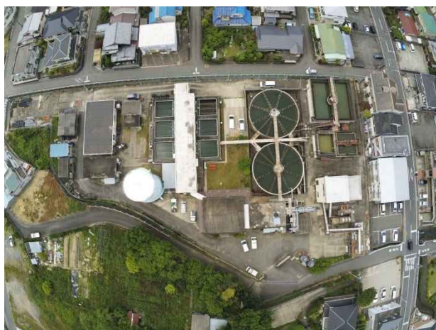
【室山浄水場】（海南水道事業）
