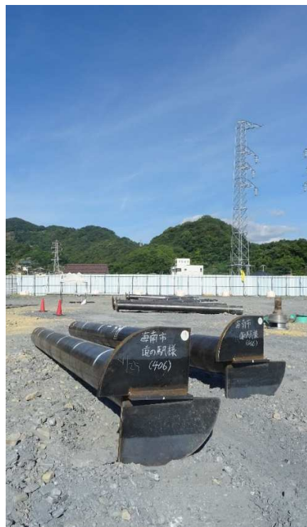
【支持杭の一部】
