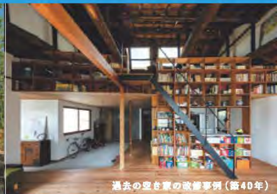
過去の空き家の改修事例(築100年)
