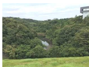
⑰ 内池（東側より）
