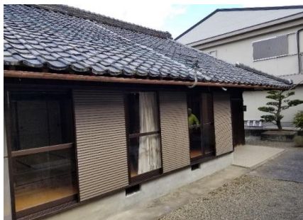
【母屋 建物外観】
