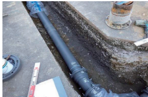
災害に強い水道管(耐震管)
