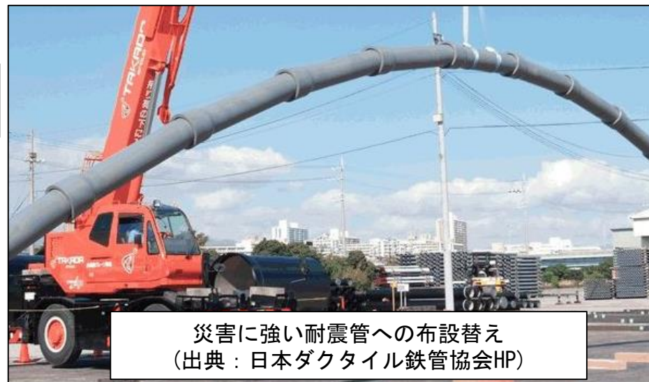
導水管の更新工事状況 (パイプインパイプ工法)
