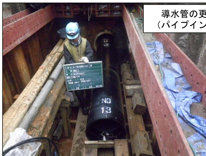
老朽配水管（鋳鉄管）
