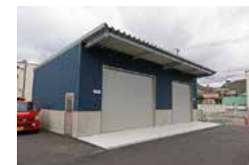
水防倉庫・集中備蓄倉庫
