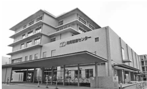
平成25年3月1日開院予定の海南医療センター
