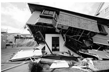
命を守る耐震シェルター(写真中央)
