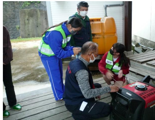
発電機試運転の様子
