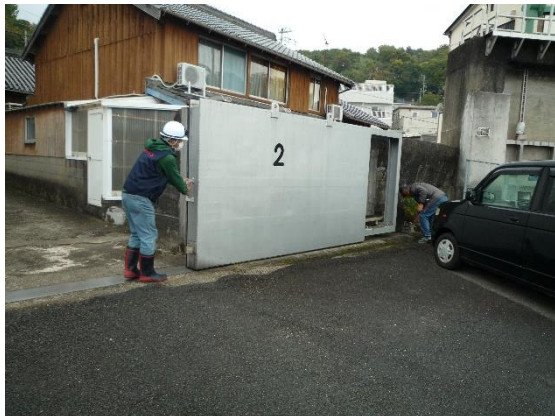
防潮扉閉鎖訓練の様子
