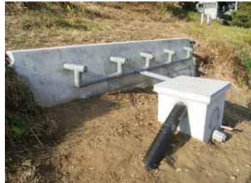
横穴ボーリングにより、地下水を排除する
