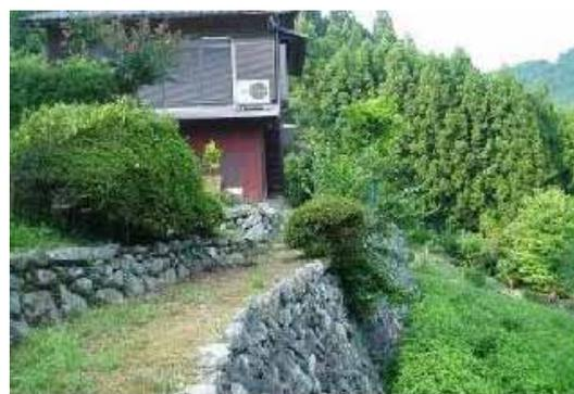
石積みで法面の崩壊を防ぐ
