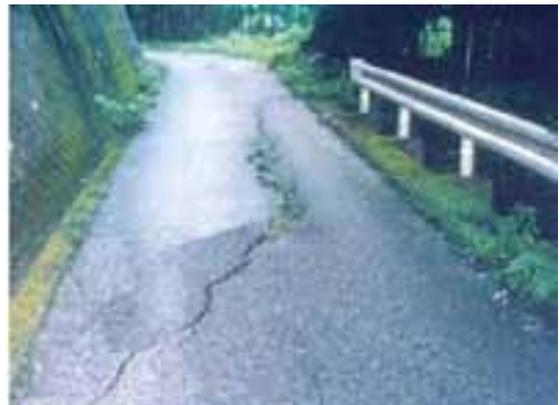
図 3-8 道路に発生した亀裂
