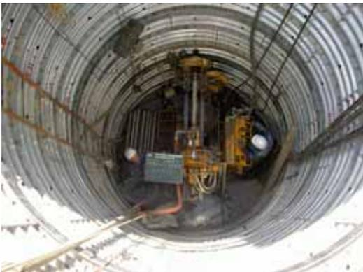
水抜きボーリング工では対応できない比較的地表から深い地下水を排除する
