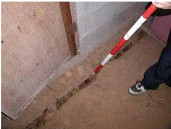
図 3-9 家屋に発生した亀裂
