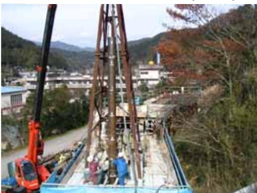
地すべりの土塊を貫いて基盤まで鋼管杭を挿入し、動きを抑止する
