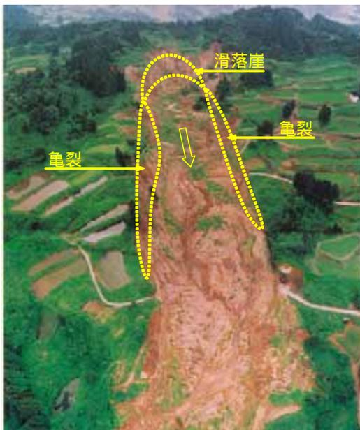
図 2-3 地すべりによって生じた馬蹄形地形
