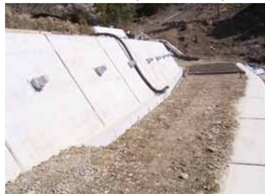
基盤岩と地すべり土塊をアンカーで結びアンカーの引張力で地すべりを安定化する
