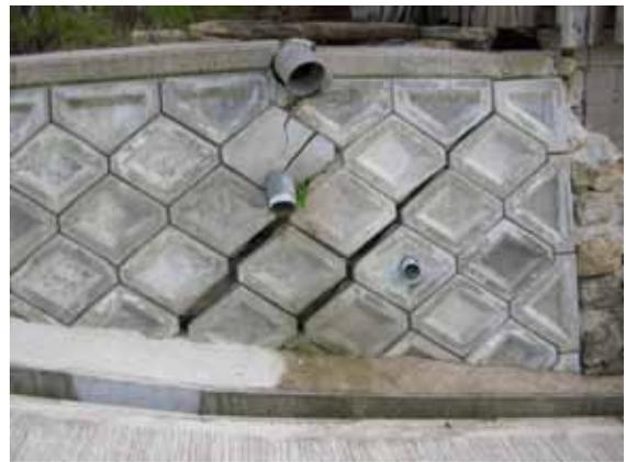
図 3-10 擁壁に発生した亀裂
