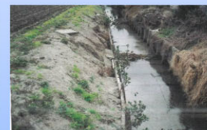
老朽水路の改修
