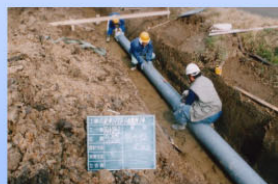
農業用水路の設置
