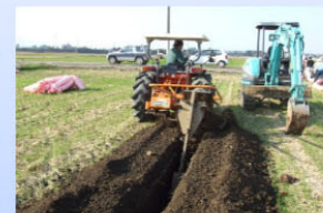
暗渠排水の設置
