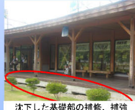
沈下した基礎部の補修、補強
