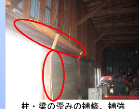
柱・梁の歪みの補修、補強
