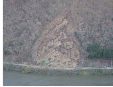
道路斜面の崩落 (東日本大震災での被災)
