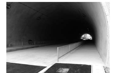
トンネル内に新しくできた歩道
