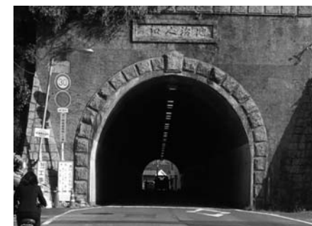
拡幅前の城山トンネル
