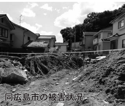
平成 26 年 8 月豪雨による土砂災害の被害状況（広島市）
