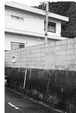
▲撤去前のブロック塀
