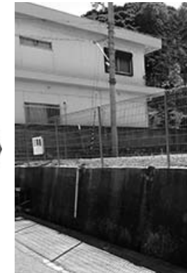
▲新設されたフェンス
